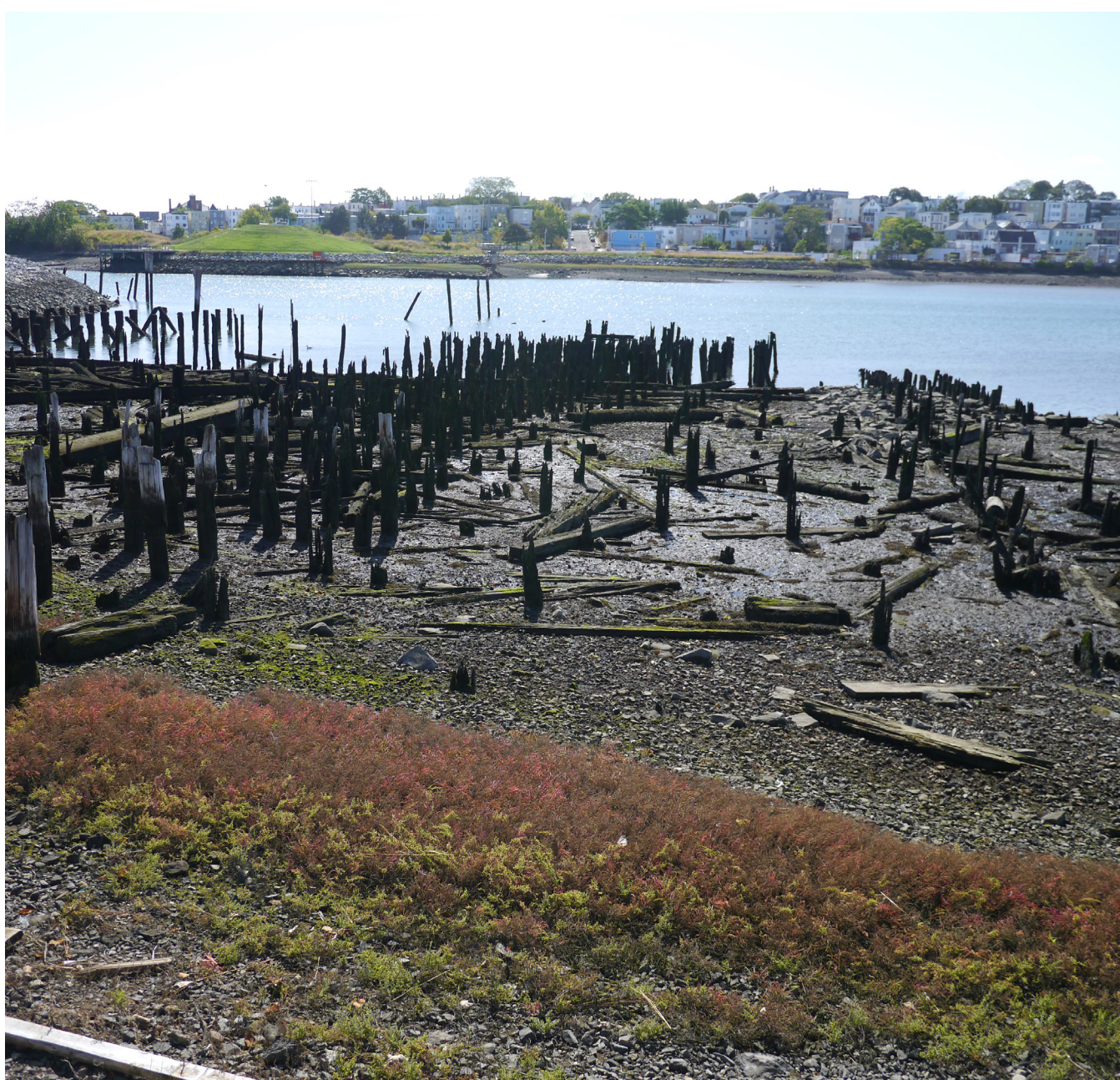
9. Pilotes expuestos en Chelsea Creek situados a la altura de la Calle Marginal
