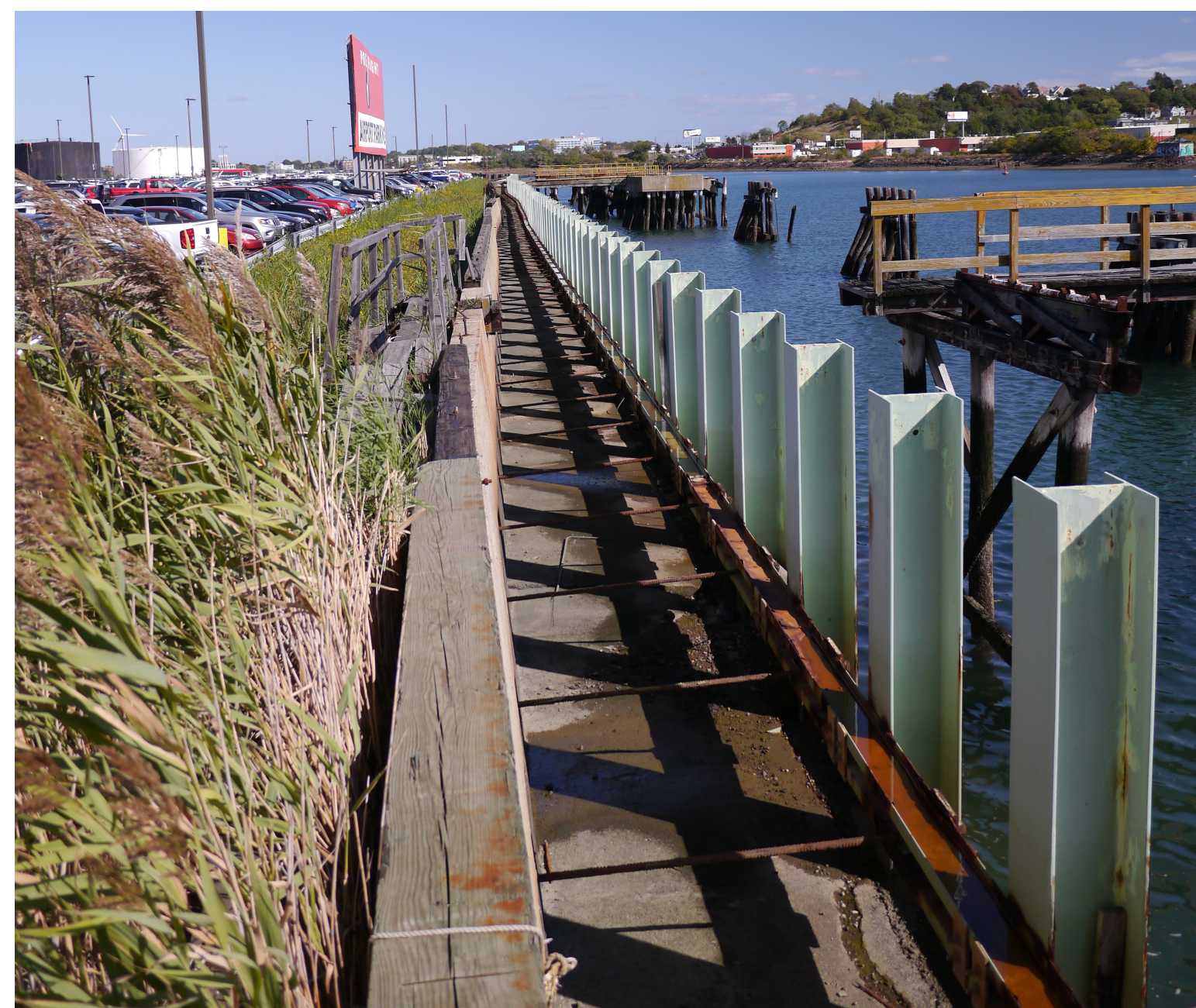
4. Paseo Marítimo en la Calle Marginal
