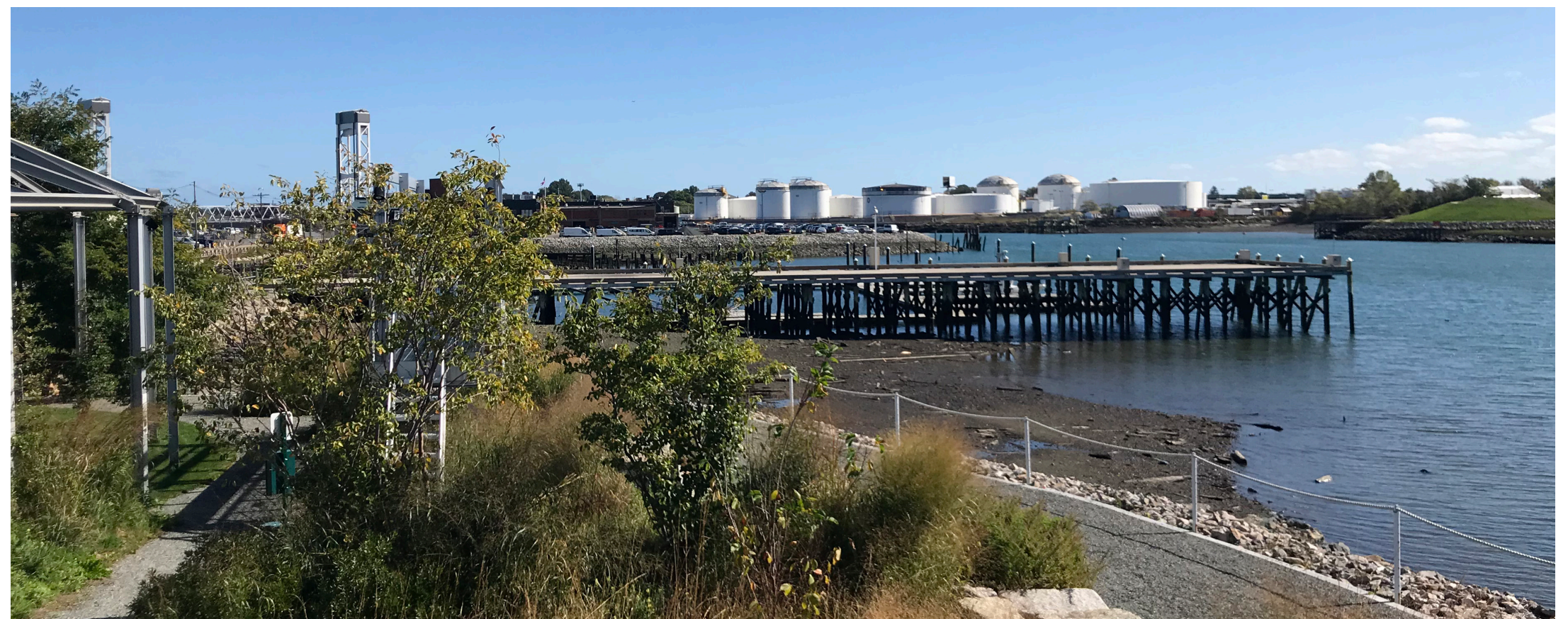
Parque PORT mirando el muelle en la Calle Marginal
